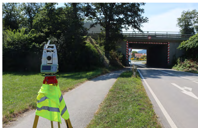
Die Vermessungsarbeiten laufen bereits
